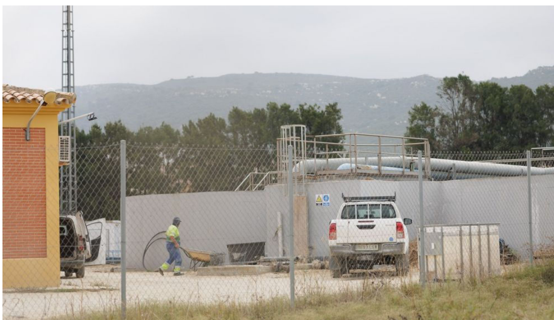
La depuradora de Atlanterra, vista desde fuera.
