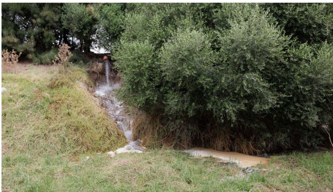
El vertido en su salida desde la depuradora. JUAN CARLOS TORO
