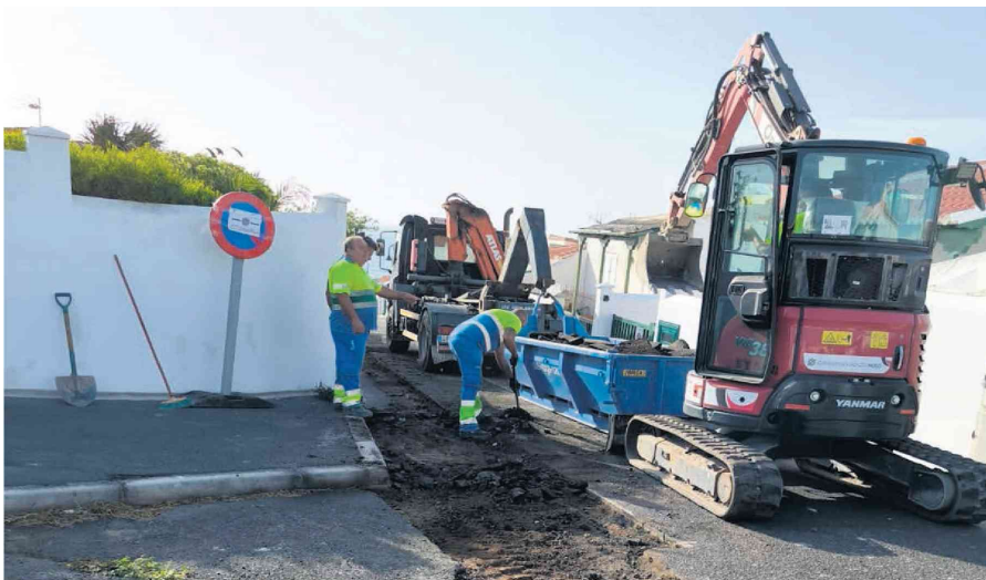
OPERARIOS MUNICIPALES TRABAJAN EN LA CALLE ATALAYA DE ABADES. DA
