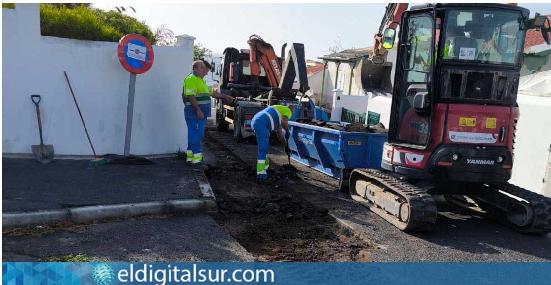
Obras en la calle Atalaya
