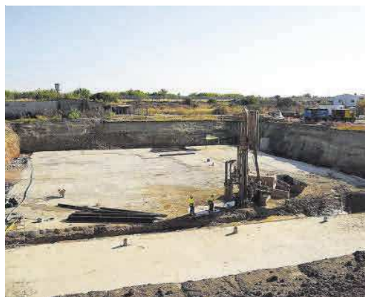
Obras de uno de los tres tanques de tormentas en Villanueva.
